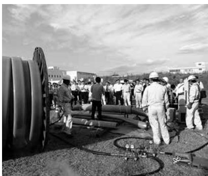
写真-4 オメガライナー工法
