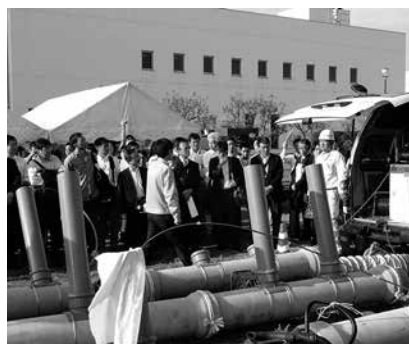
写真-9 取付管部の穿孔工法
