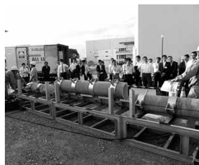
写真-8 FFT-S工法
