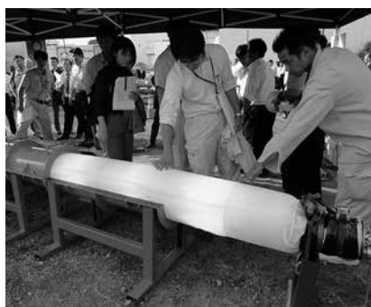
写真-6 シームレスシステム工法
