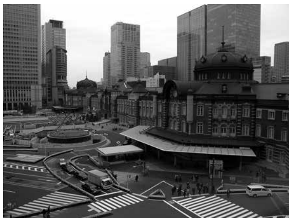
写真-1 東京駅丸の内駅舎
