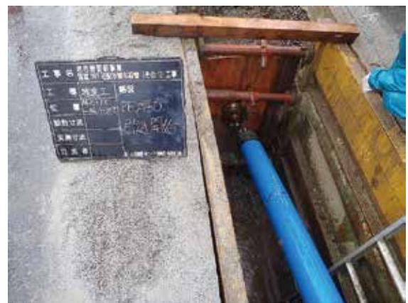
写真-5 埋設管引込開始
