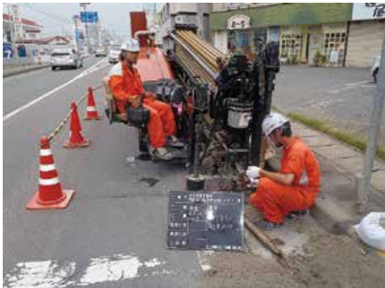
写真-7 ドリルマシン設置状況
