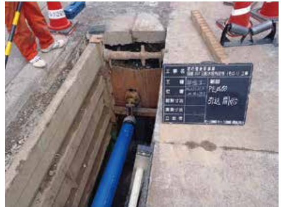
写真-10 ポリエチレン管引込開始
