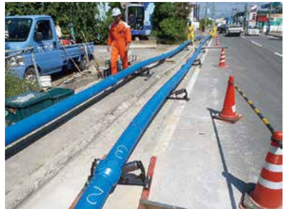
写真-11 ポリエチレン管融着状況
