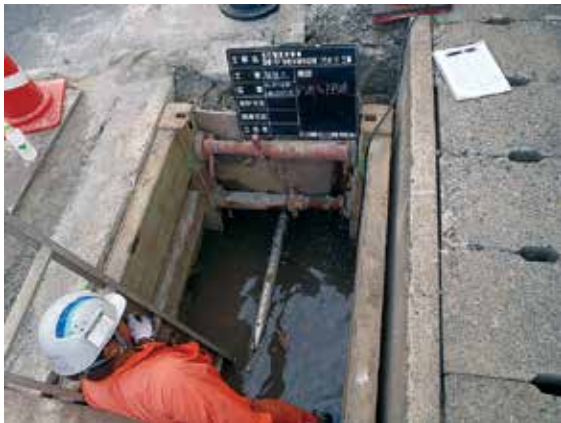
写真-9 ドリルヘッド到達状況
