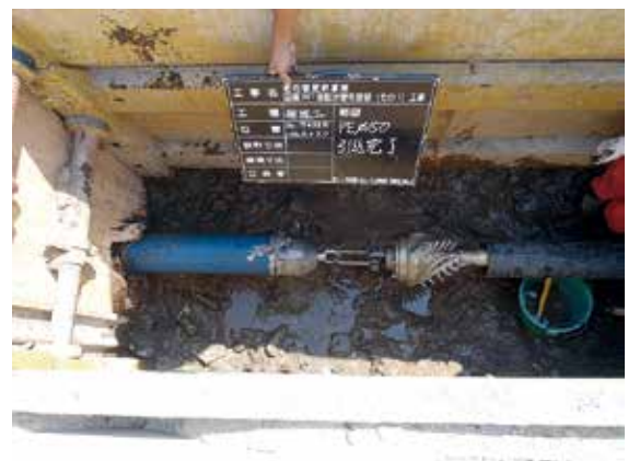
写真-6 埋設管引込完了
