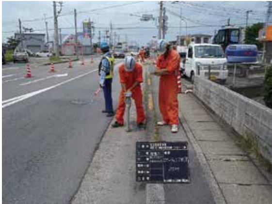
写真-8 位置計測状況
