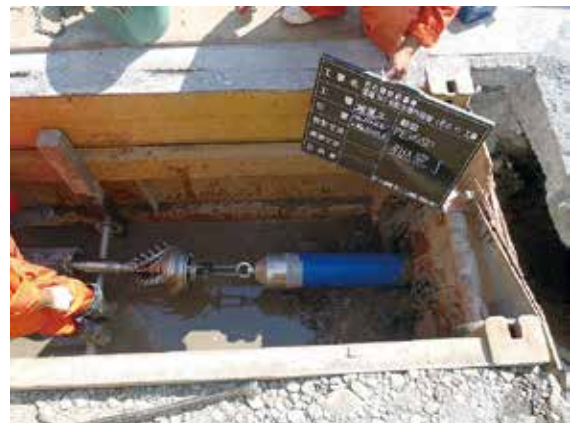
写真-12 ポリエチレン管到達状況
