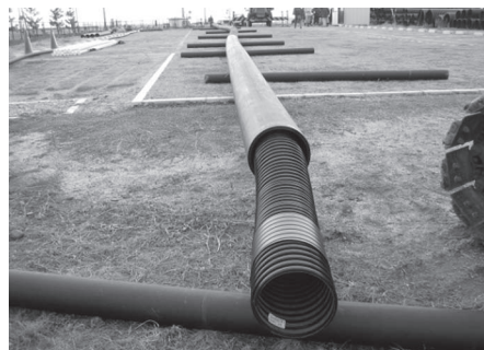
写真-2 実験ドレーン管
