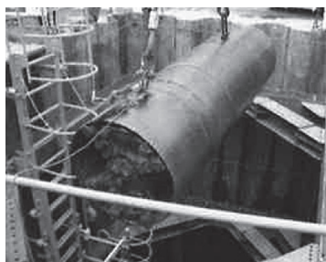
小口径管推進工法
