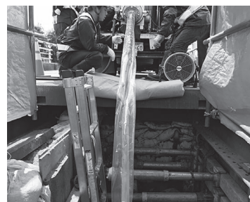
パルテム工法
