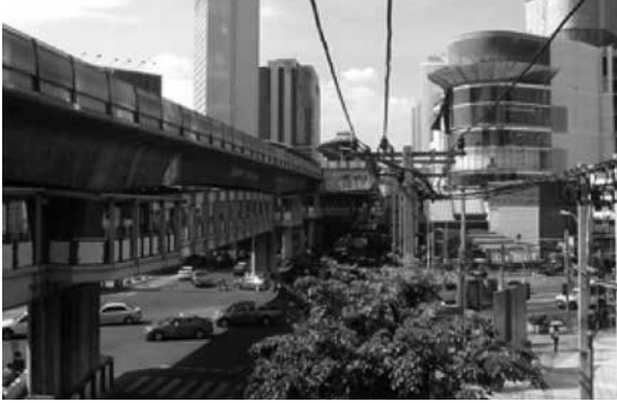
写真-1 バンコクの高架鉄道B T S 沿線の高層開発
