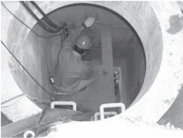
写真-4 深いマンホール
