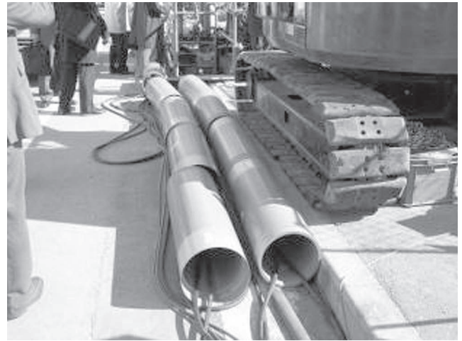
写真-5 新設管 (φ 300mm 塩ビ推進管)
