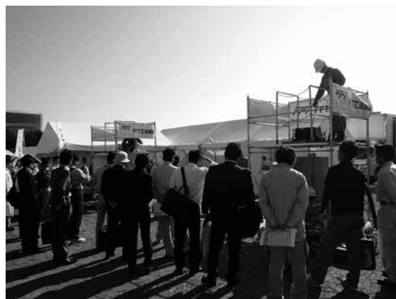
写真-5 デモ施工の様子(形成工法)
