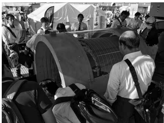
写真-4 デモ施工の様子(製管工法)
