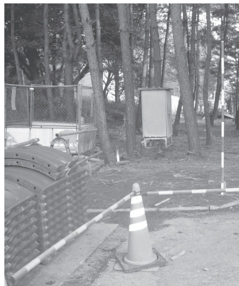
写真-8 路線状況（地上部）
