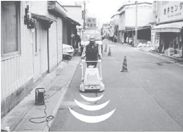
写真一 路上からの周辺埋設管等の調査
