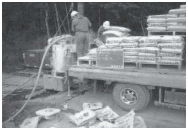
写真-1 従来工法の作業状況①
