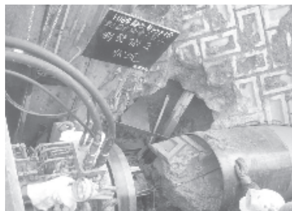
写真-1 発進部コンクリート壁切断
