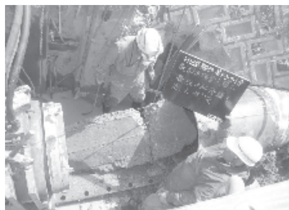
写真-2 既設 \phi 600 HP管引き抜き
