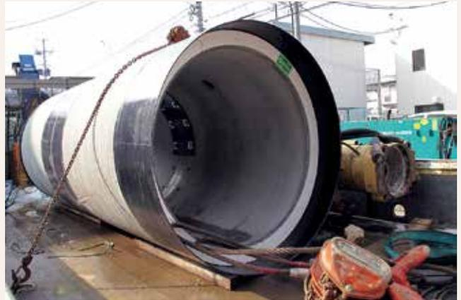
▲  $\phi 900\text{mm}$  推進管
