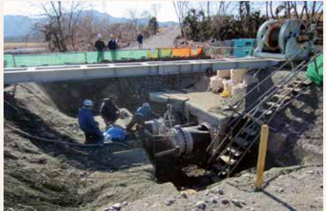
▲ 水圧復元・耐圧漏水試験
