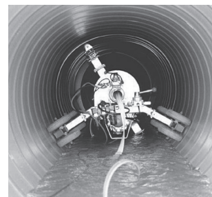
ダンビー工法施工中
