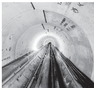
ミニシールド坑内
