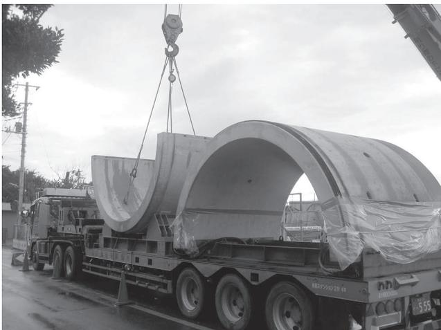
写真-2 呼び径3500超大口径管分割型RC推進管
