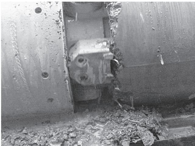
写真-4 推進工法による管渠の改築（環状切削推進工法）
